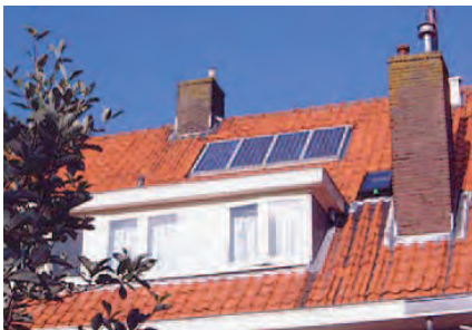
Voorbeeld van een zonnecentrale met vier 120 Wp zonnepanelen, geschikt voor de Soladin. Piekopbrengst: 480Wp. Energiebesparing, afhankelijk van het verbruik, tot 12%.
